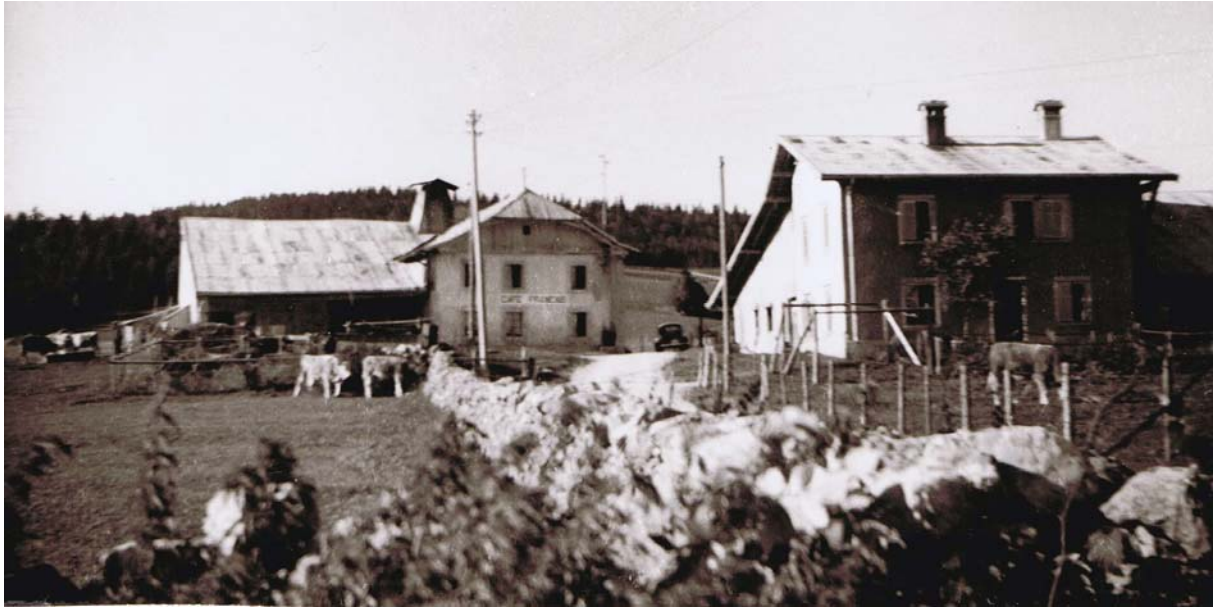
A gauche b) Café Français, à droite c) Chez Dépraz, qui vient d'être entièrement remaniée, avec une adjonction qui reste bien entendu une erreur architecturale qui va modifier de manière sensible l'aspect général du hameau.
